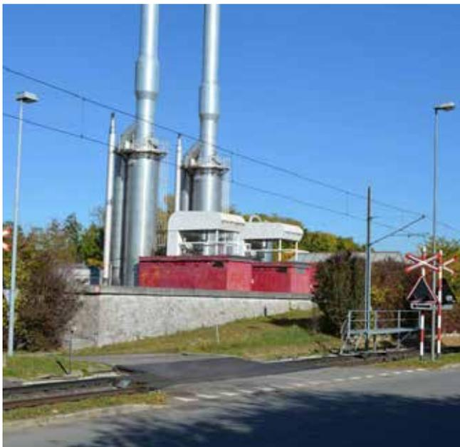
**Problem:** Die bestehende Heiz- und Kühlinfrastruktur der EPFL und der Universität Lausanne war absolut veraltet, ineffizient und kohlenstoffintensiv. Der Universitätscampus wurde über ein Wärmekraftwerk und die Pumpstation Pierettes beheizt, die aus zwei Wärmepumpen mit zwei ölbefeuerten Turbinen besteht.
